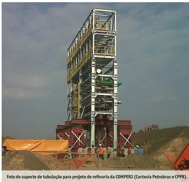
Foto do suporte de tubulação para projeto de refinaria da COMPERJ (Cortesia Petrobras e CPPR).
