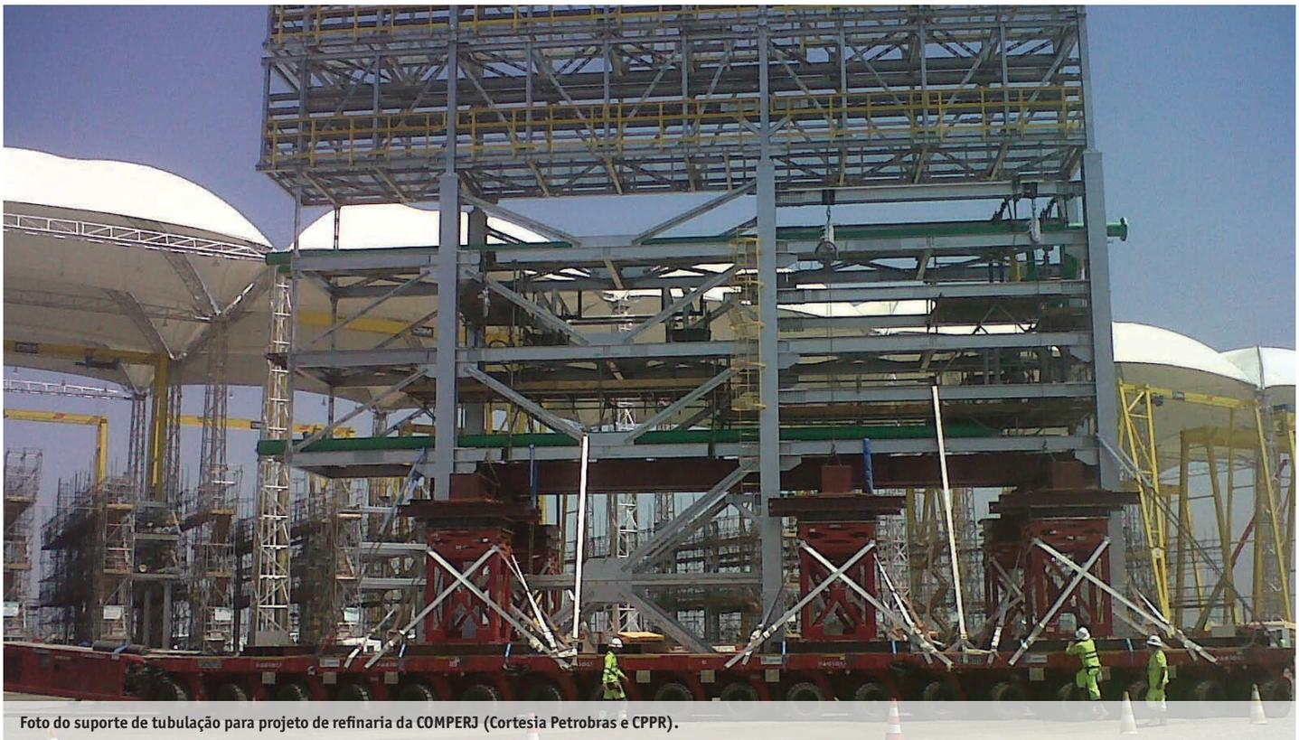
Foto do suporte de tubulação para projeto de refinaria da COMPERJ (Cortesia Petrobras e CPPR).
